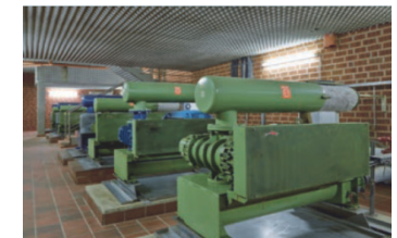
Controle de ventilação com eficiência energética
