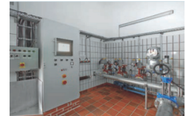
Monitoramento de fluxo e nível de água em estação de tratamento de esgoto
