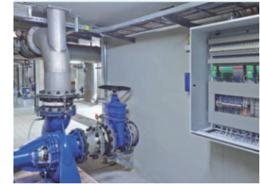
Fonte de alimentação ininterrupta na rede de distribuição
